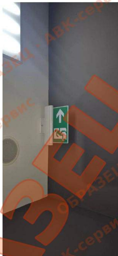
Фото 8. п.7 ВД — световой указатель «Выход»: автономная работа менее 1 ч
