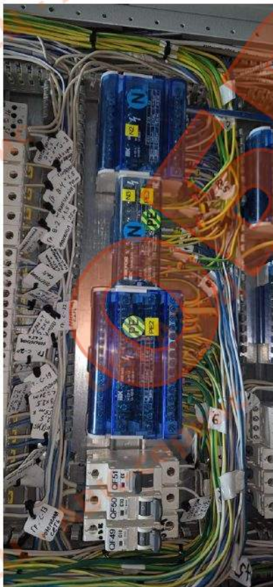
Фото 5. п.4, п.14 ВД — гр. QF49-QF51: распределение по фазам не по проекту, маркировка не соответствует фазам
