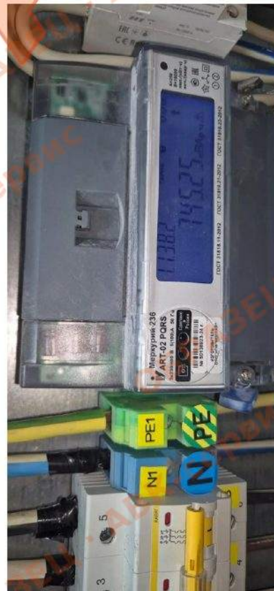
Фото 3. п.4 ВД — установлен счётчик Меркурий 236 вместо Меркурий 230 по проекту Фото 4. п.4, п.14 ВД — гр.QF53, QF54 проектом не предусмотрены; гр.45-48 через KM8; маркировка гр.49-54 не соответствует фазам
