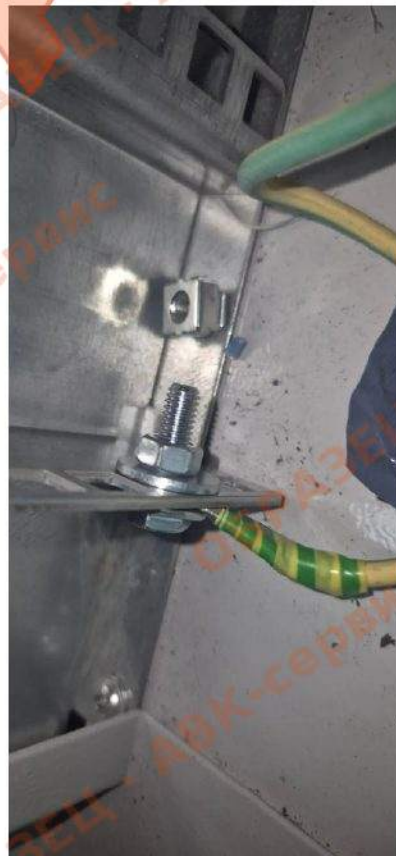
Фото 11. п.9 ВД — болтовое соединение заземления без средств против ослабления контакта
