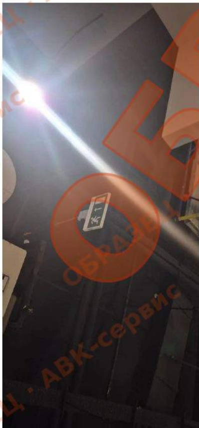
Фото 9. п.7 ВД — световой указатель «Выход»: автономная работа менее 1 ч
