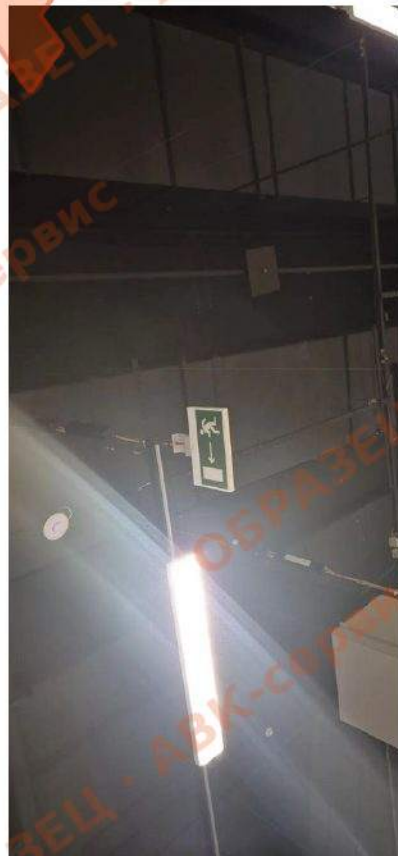
Фото 7. п.7 ВД — световой указатель «Выход»: автономная работа менее 1 ч
