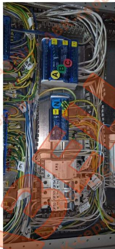
Фото 3. п.4 ВД — установлен счётчик Меркурий 236 вместо Меркурий 230 по проекту Фото 4. п.4, п.14 ВД — гр.QF53, QF54 проектом не предусмотрены; гр.45-48 через KM8; маркировка гр.49-54 не соответствует фазам
