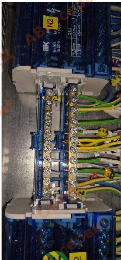
Фото 14. п.11, п.12 ВД — проводники 1,5 \text{ мм}^2 в винтовых зажимах шин N/PE; более одного проводника под зажимом
